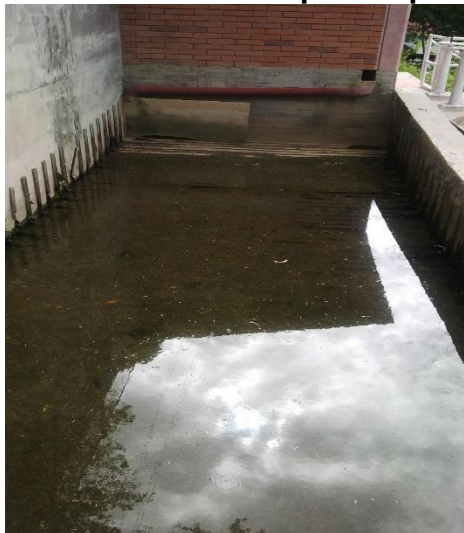
Figura 3 Floculador sin placas planas
