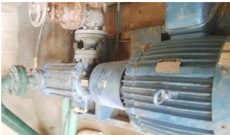
Figura 5 Bomba de 75 HP marca Siemens
