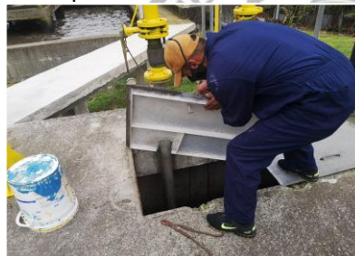
Figura 9. Cambio de bombas sumergibles
