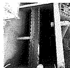
Instalación de paneles ABS sedimentación
