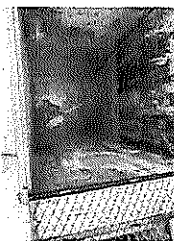
Limpieza, aplicación de pañete técnico y aplicación de pintura impermeabilizante
