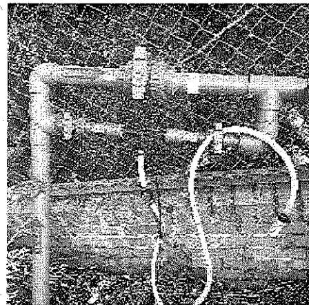
Ilustración 10. Suministro de sistema de dosificación tipo Venturi
