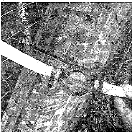
Ilustración 11. Controlador de descarga del sistema Venturi
