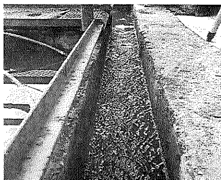
Imagen 60. Resalto hidráulico, ruptura de floc
