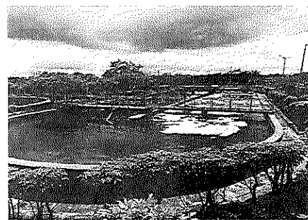
Imagen 87. Zanjón de oxidación
