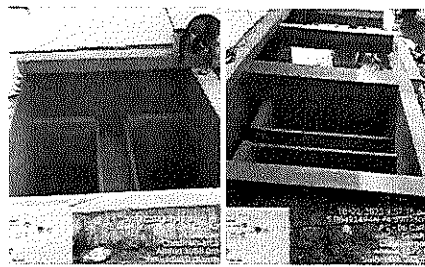
Imagen 72. Cambio de lecho filtrante
