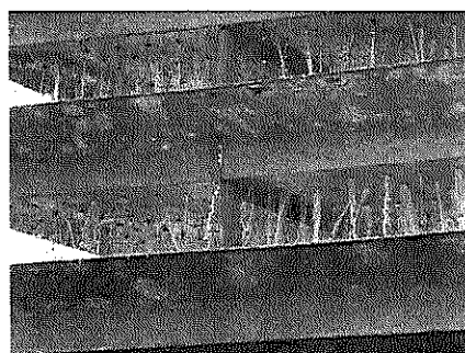
Imagen 3. Agrietamiento y daño en bandejas Antes
