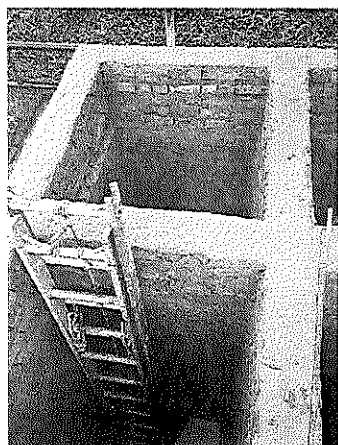
Imagen 65. Levantamiento de muros floculador
