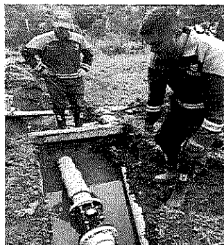
Imagen 75. Instalación de macromedidor
