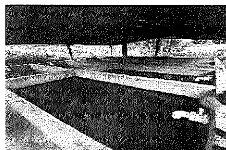
Imagen 95. Lechos de secado de lodos
