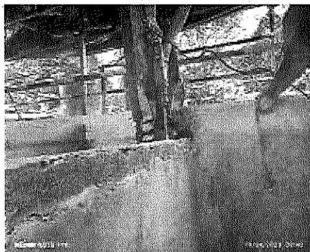
Figura 5. Eliminación del resalto hidráulico en floculador
