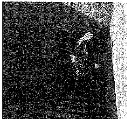
Figura 34. Lavado y descolmatación de estructuras
