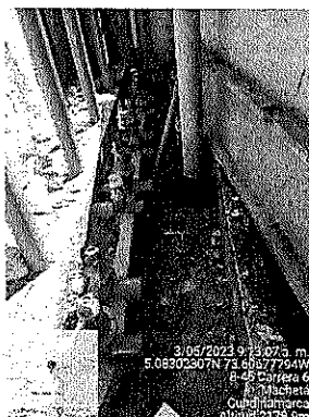
Figura 16. Cambio de valvulería
